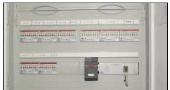
Das REG-Gerät wurde jeweils in der Verteilung platziert und kann bei Bedarf einfach abgeklemmt werden, so dass die Haustechnik des jeweiligen Gebäudes dann voll funktionsfähig als »Insel« weiterläuft.
