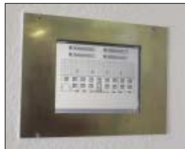
Das REG-Gerät wurde jeweils in der Verteilung platziert und kann bei Bedarf einfach abgeklemmt werden, so dass die Haustechnik des jeweiligen Gebäudes dann voll funktionsfähig als »Insel« weiterläuft.
