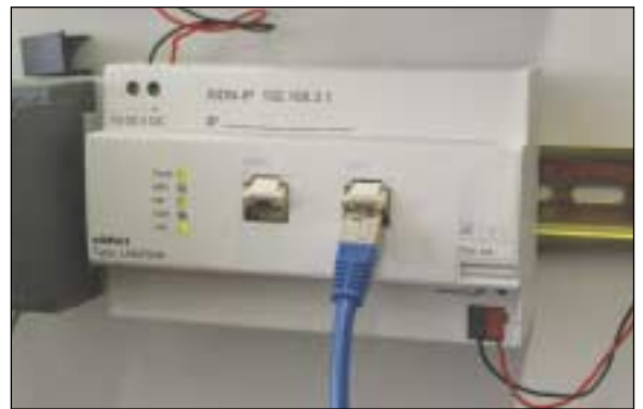
»eibPort« verbindet als Gateway die EIB-Welt mit Ethernet und ISDN-Netz und stellt über Glasfaser und LAN die Verbindung zu den anderen Gebäuden her.
