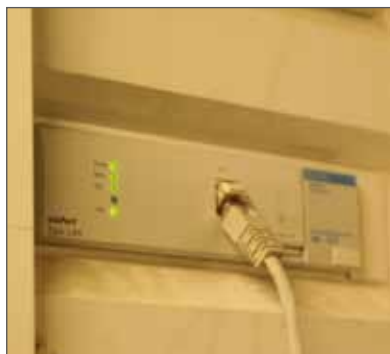
Der eibPort: Hierüber erfolgt die Visualisierung und der Weg ins Internet. So kann der Küster auch vom heimischen Schreibtisch aus sehen, ob alles in Ordnung ist.
